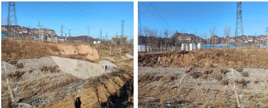
图 5.3-15 项目厂区东侧冲沟现状
