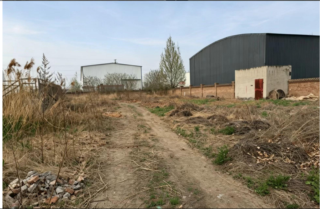
图 2-2 升压站现状照片
