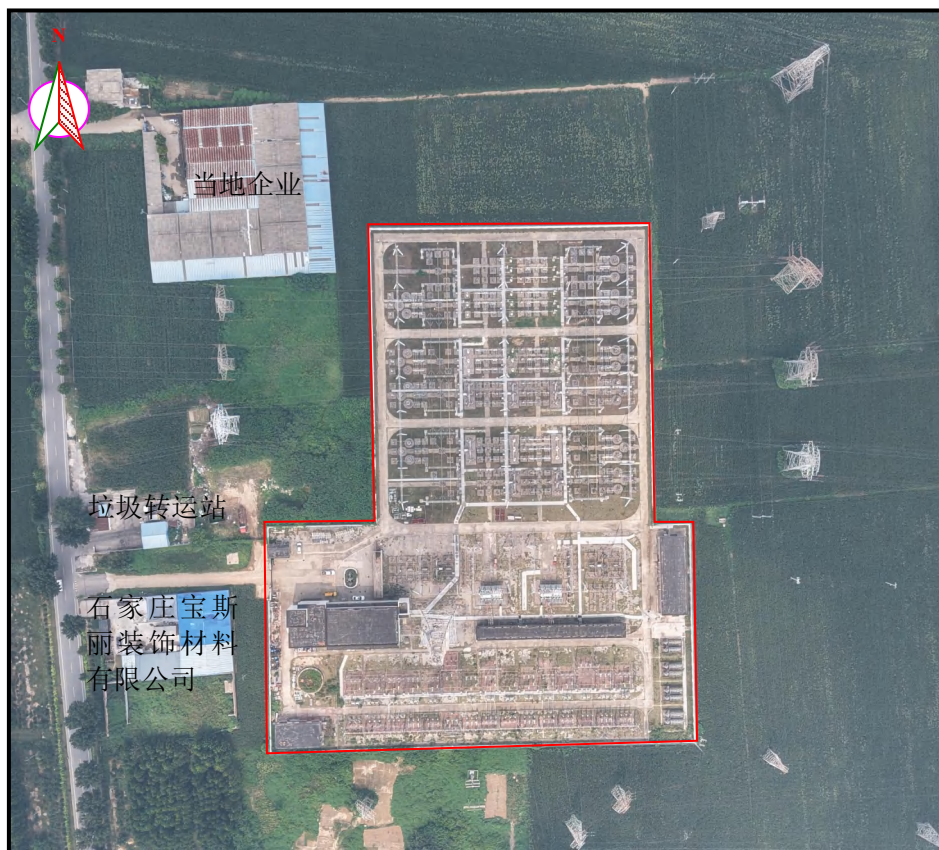
图 2-1 常山 220kV 变电站现状航拍照片
