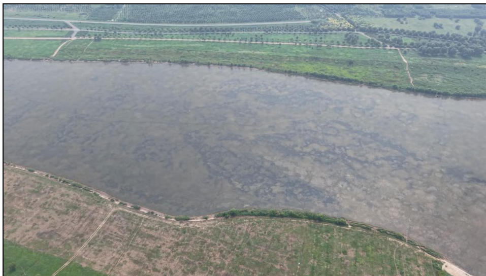
图 3-2 跨越滹沱河处现状
