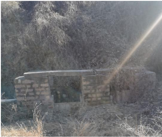
张楞支渠分水闸
