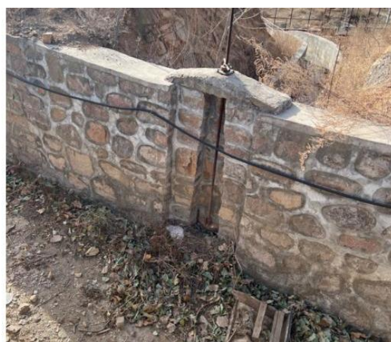
田村南支渠分水闸
