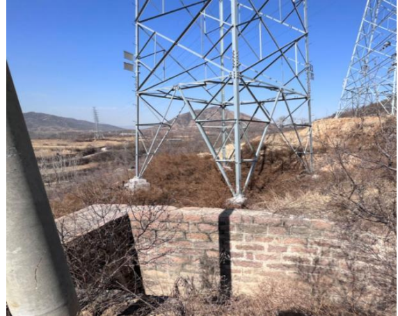
药材基地支渠
