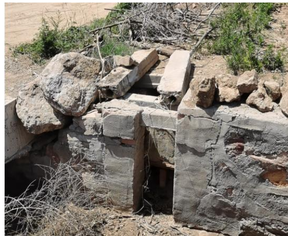
延庄 3#斗口分水闸
