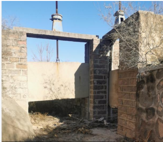
北潘节制分水闸
